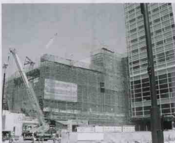
万代島美術館 建設現場(外観)
