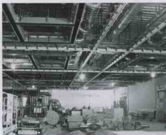
万代島美術館 建設現場(展示室)
